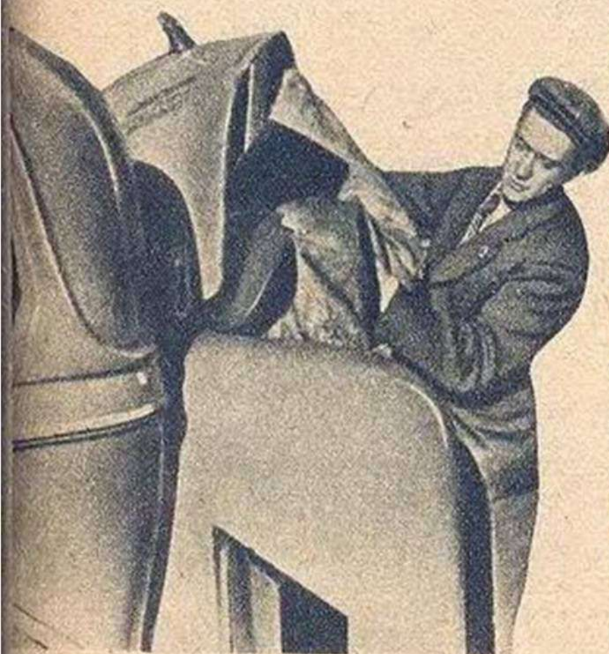
Загрузка дров в газогенератор.
