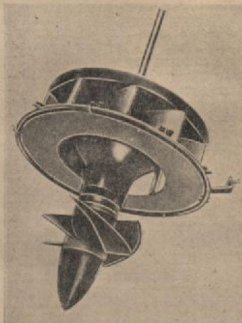
Фиг. 138. Модель деревянной пропеллерной турбины, испытанной ВНИИГиМ в 1946 г.
